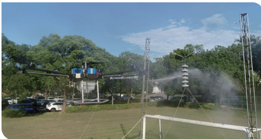
ドローンによるがいしの洗浄作業
